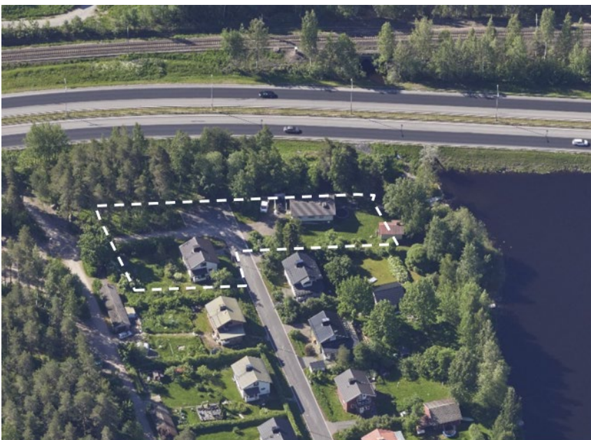
Niitynpään Säilyke-alueen eteläosaa pohjoisesta päin katsottuna. Vaajakosken moottoritie kulkee aivan alueen vierestä. Melunsuojaurakenteita ei ole toteutettu. Kaksi eteläisintä tonttia rakennuksineen poistuu asemakaavasta tien ja meluseinän rakentamisen takia. Näköyhteys Vaajakosken moottoritien suuntaan katkeaa.
