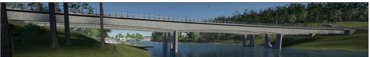
Vaajavirran ylittävä silta Päijänteen suunnasta katsottuna. Taustalla kaukana häämöttää voimalaitos.
